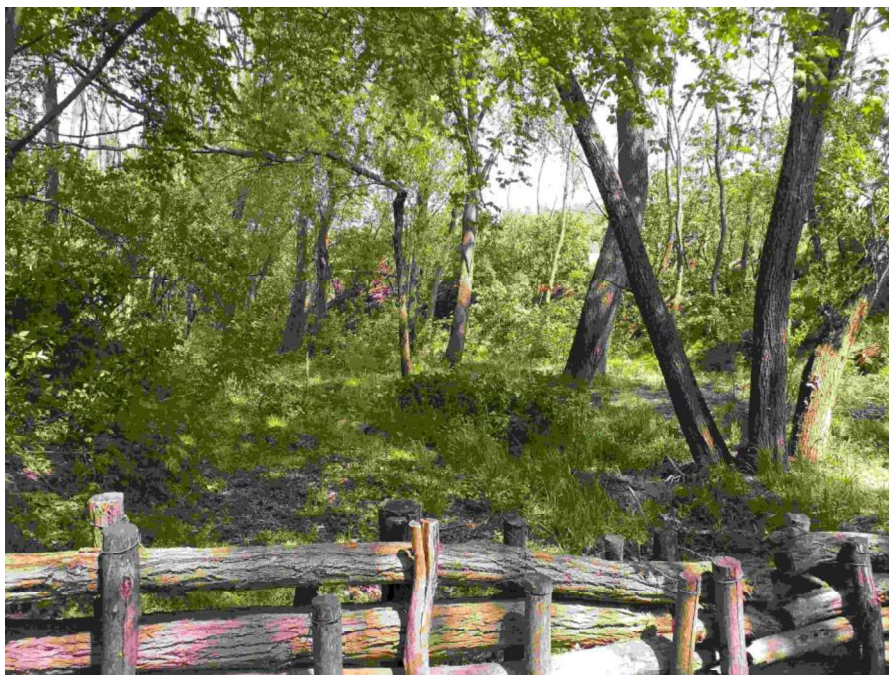
20. ábra A rönkgát felvizi oldala időszakos tározótér. „Valódi”, tartós víztározás nem történik, hanem a gát alatti nyílást meghaladó vízmennyiség torlódik vissza, majd ürül le automatikusan a nyíláson. A felszíni lefolyás ezáltal időben elnyújtható. A megoldás nem azonos a medret elzáró, hordalékot visszatartó rönkfallal. Ugyanez a hatás benőtt mederrel is jelentkezik. (Saját fotók)
