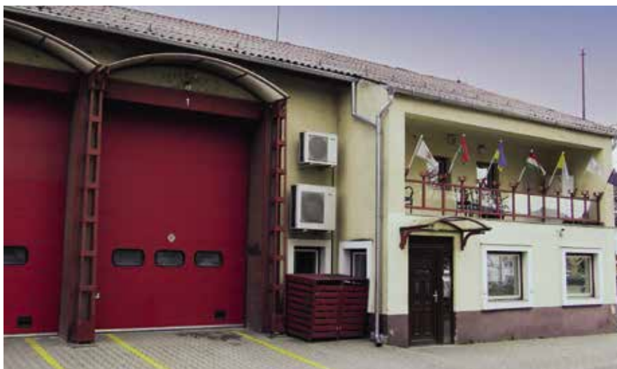
► Energetikailag korszerűsítik a tűzoltóság épületét
