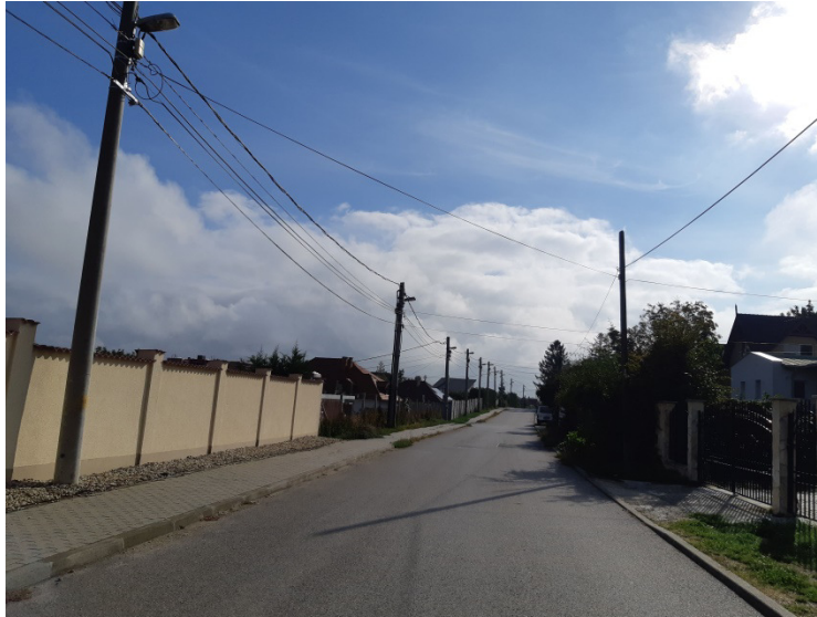
12. kép: Boglárka utca jelenlegi állapot (Tél utca felől Töhötöm utca felé)
