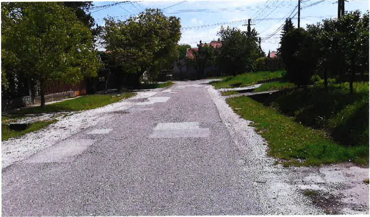
Mátyás király utca Toldi Miklós utcához való csatlakozása, a burkolat felújítás tervezési szakaszának vége
