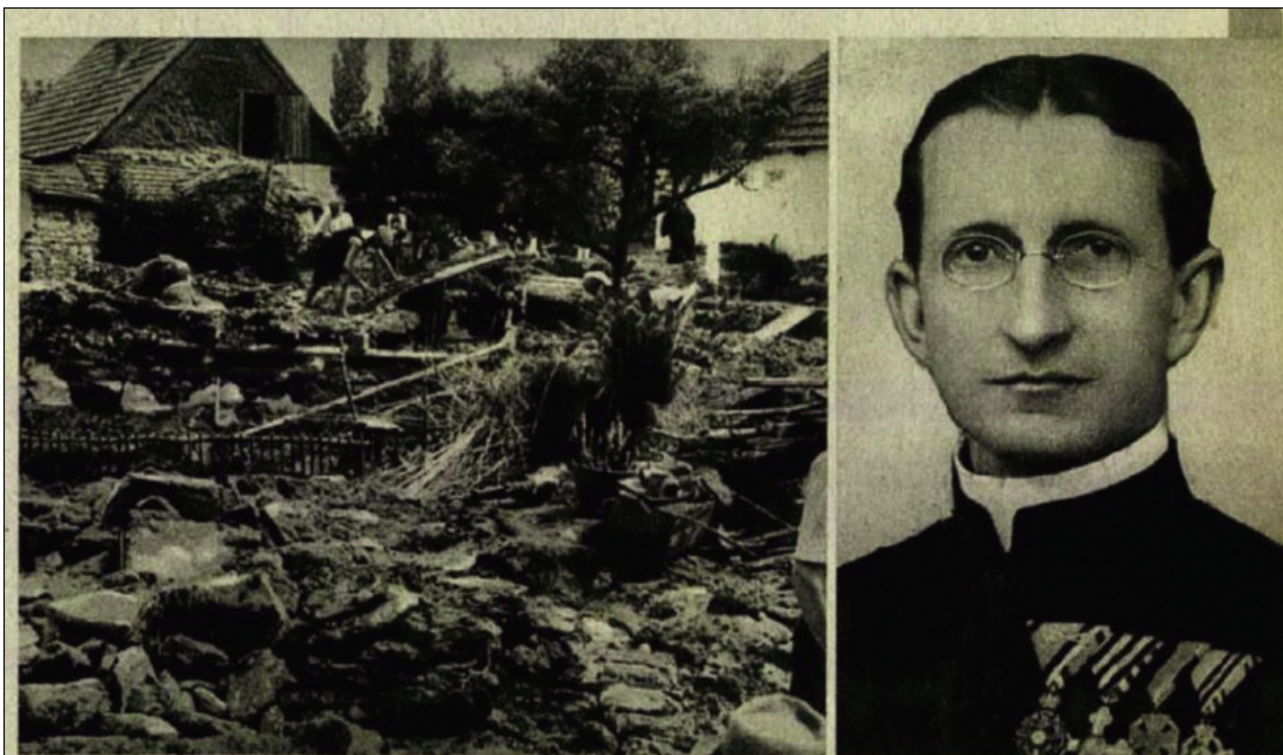
Itéletidő pusztított Budapesten és környékén példátlanul nagyarányú felhőszakadás kíséretében. Pomázon (baloldali kép) házakat rombolt össze, feltépte a vasúti síneket, hídakat söpört el és emberéletet is követelt. A fékétvesztett áradásban lelte halálát vitéz dr Horváth József plébános is (jobboldali kép), aki mentés közben fulladt a szennyes vízbe. Óriási részvételt temették el a hősi halált halt, nemesszívű népszerű papot.
