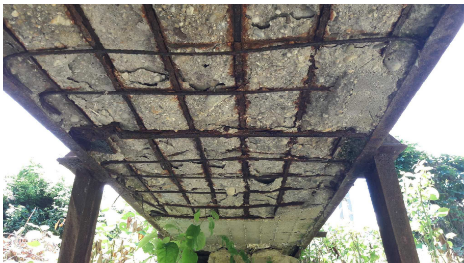
12. ábra: a híd pályalemezének tönkremenetele
