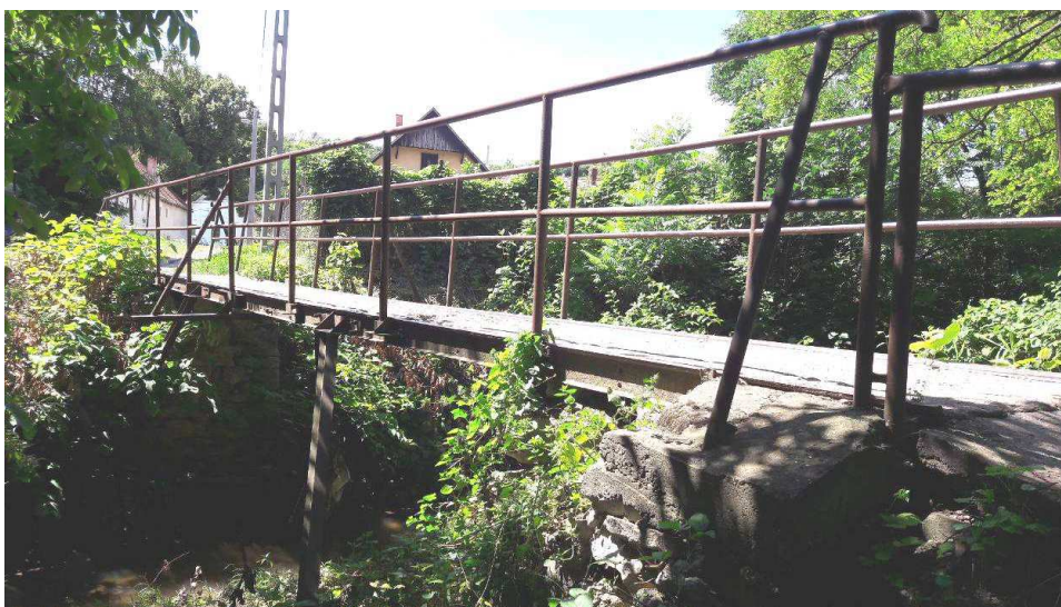
6. ábra: a híd oldalnézete alvízi oldalról fotózva
